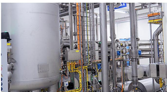
Feedeinheit mit CIP/Permeat - Tank
