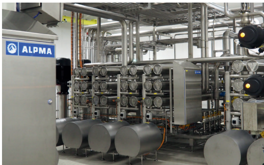
Fonterra bestätigt: ALPMA/LTH wickelte das Projekt deutlich über dem „normalen Standard“ ab (Foto: mi)
